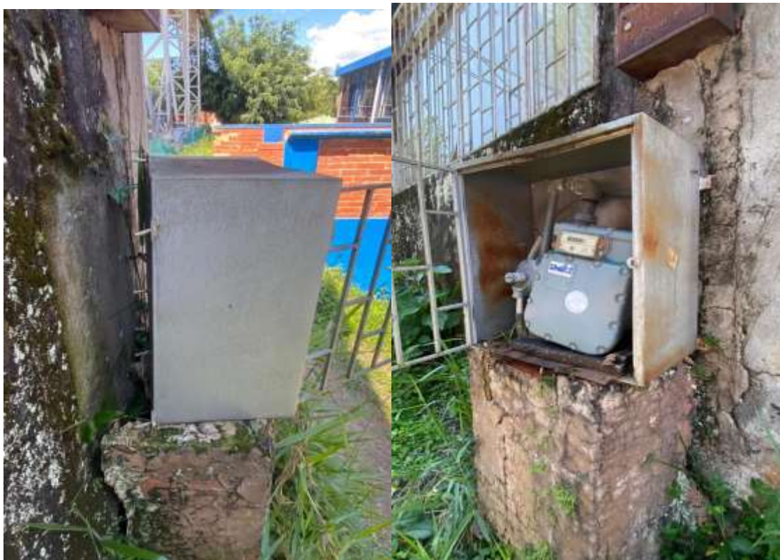
Instalación del gas
