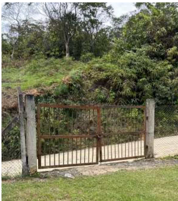
Figura 1. Portón principal de acceso a la sede
